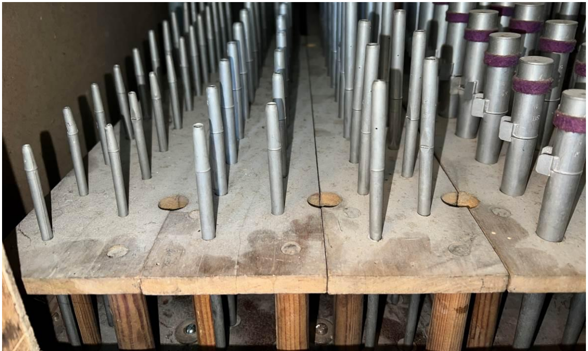
Abbildung 9 Verstaubte Rasterbretter im Schwellwerk
