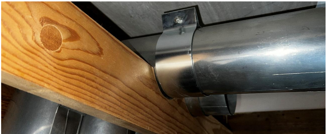
Abbildung 3 Hinzugefügte Zinkringe zur Stabilisierung der Prospektpfeifenkörper (Prinzipal 8')
