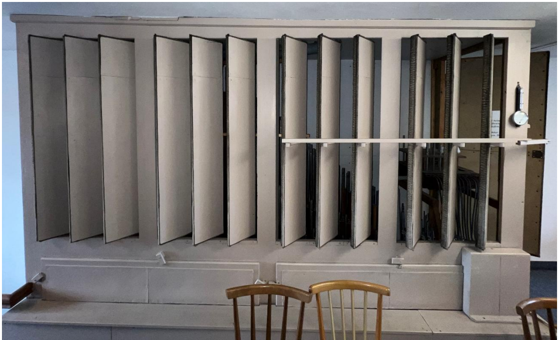
Abbildung 26 Sicht auf das Schwellwerk
