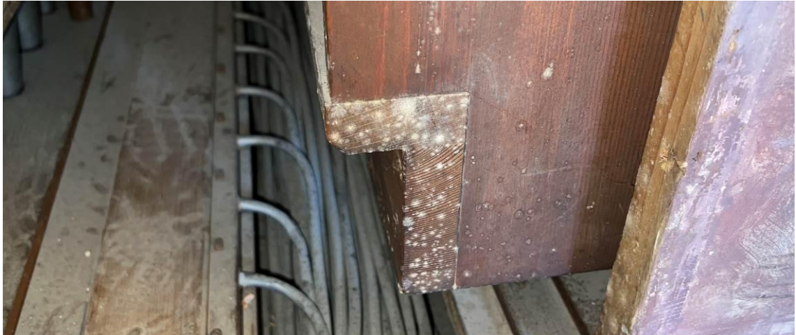
Abbildung 8 Schimmelbefall an den Holzpfeifen
